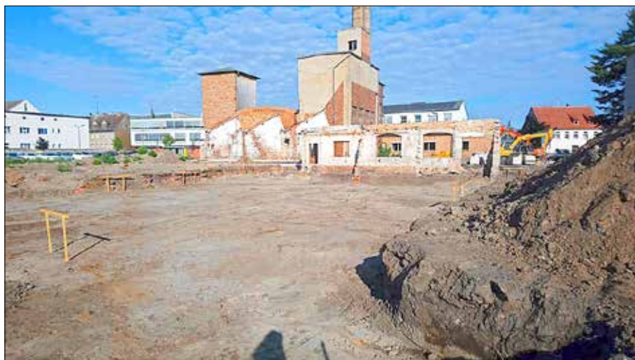
Fertigstellung der Baugrube
