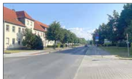
Sanierung der L62 - Planung beginnt 2021
