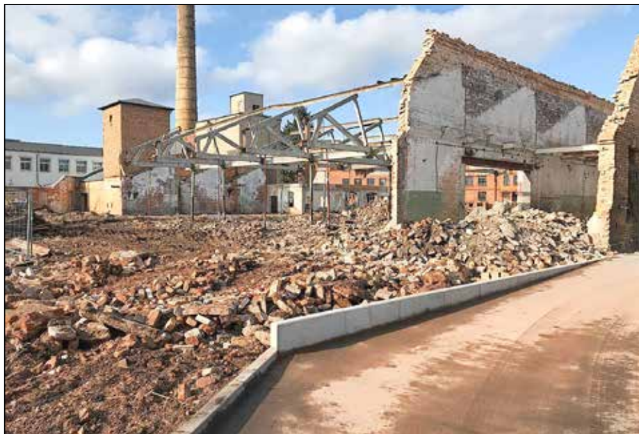
Fortsetzung der Abbrucharbeiten im März dieses Jahres
