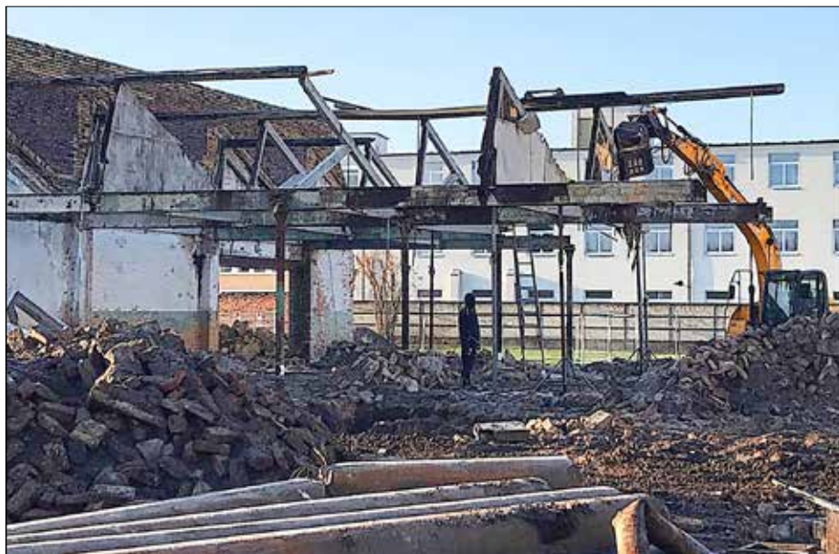
Bergung verbliebener Binder und Stahlträger nach dem Sturmschaden
