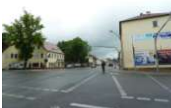
Blick in den Straßenraum Sonnewalder Straße von Kreuzung Kirchhainer Straße
