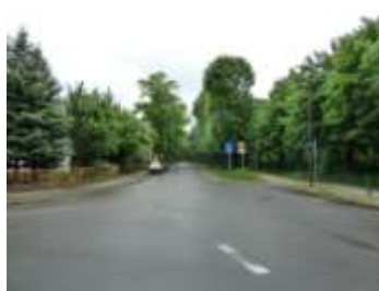
Blick in den Straßenraum Forststraße aus Richtung Tuchmacherstraße
