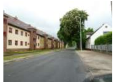
Blick in den Straßenraum Eichholzer Straße in Richtung Ortsausfahrt Eichholz
